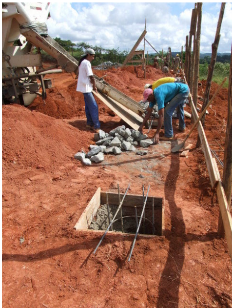
Aspectos da concretagem dos primeiros tubulões
