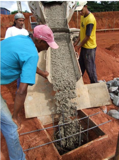
Aspectos da concretagem dos primeiros tubulões
